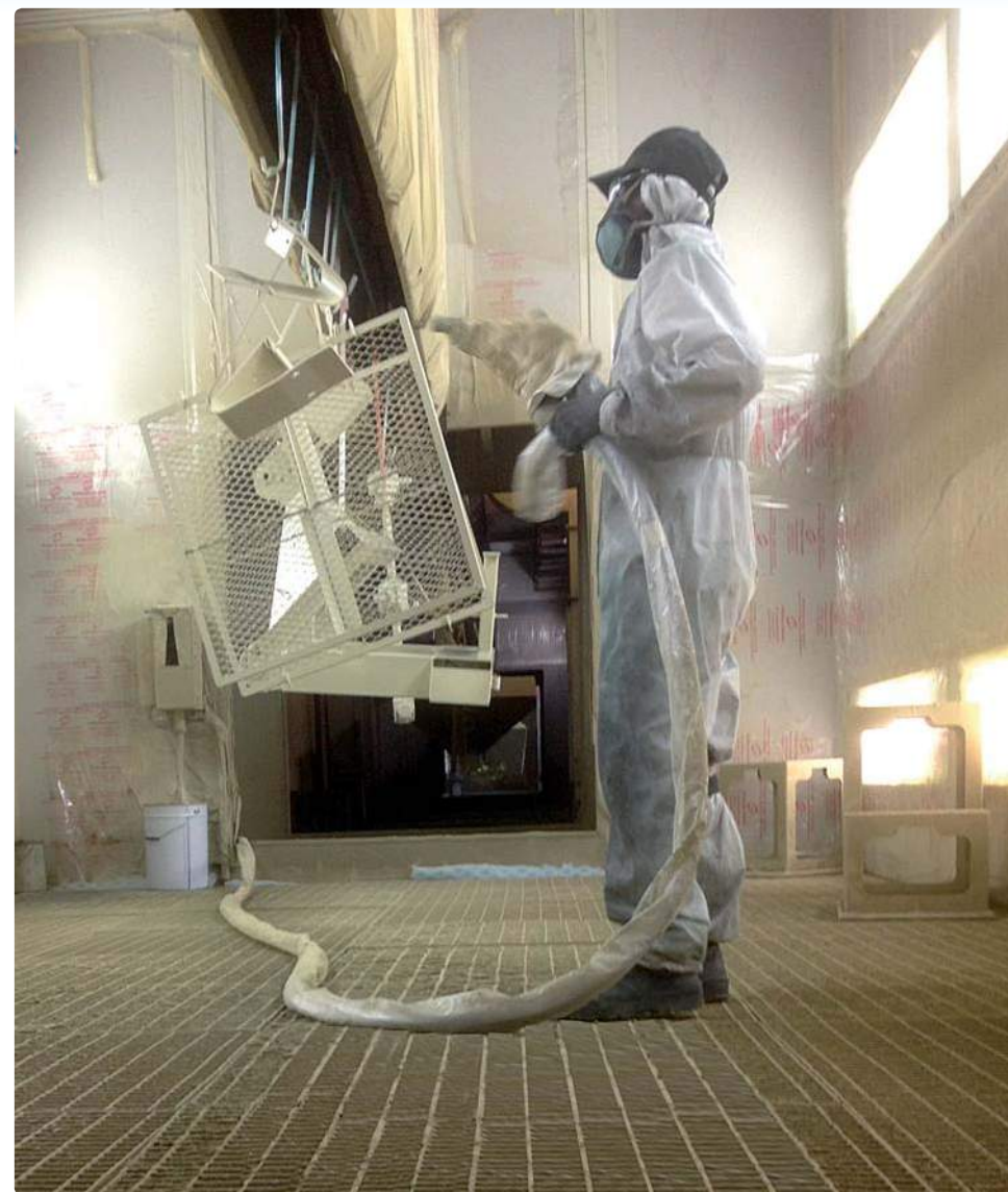
Tweede anti-roest laag en laklaag
